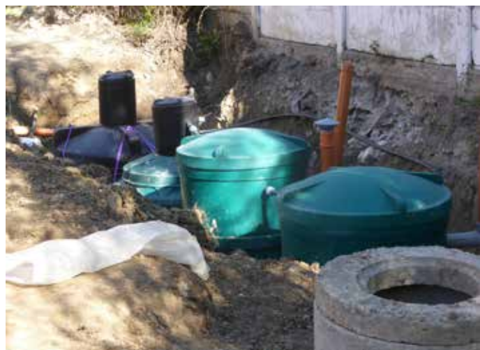
Bio Kläranlage während der Bauzeit
