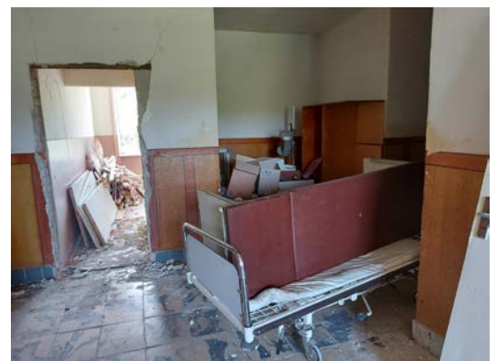
Bau von Flüchtlingsunterkünften im Krankenhaus
