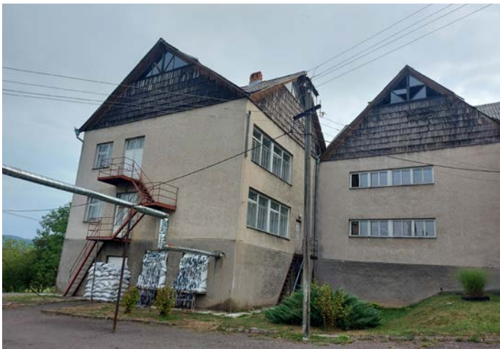
Schule Saritschewo, Sicherung der Schutzräume mit Sandsäcken
