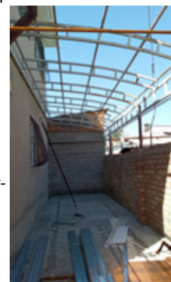
der neue Seminarraum noch als Baustelle
